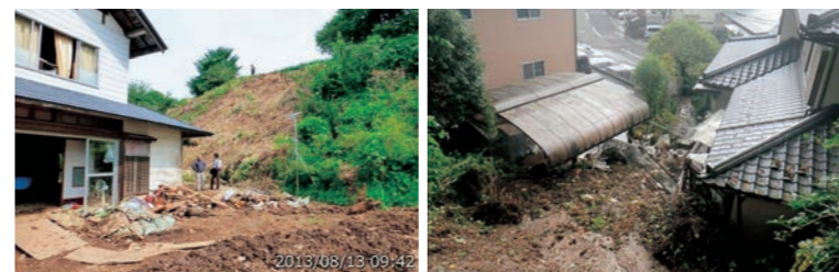
H25年8月 岩手県花巻市 H29年10月 宮城県富谷市
